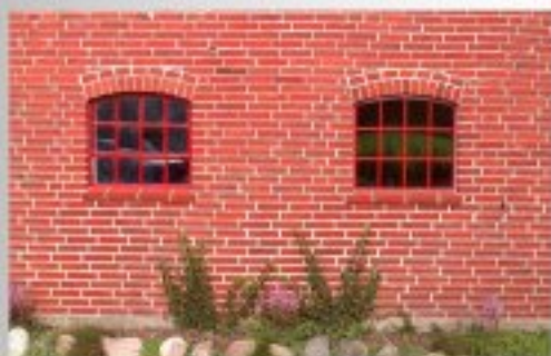
Vinduet til venstre er støbejern. Vinduet til højre er lavet af Alscan.
